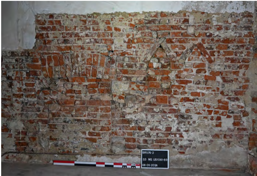
Fig. 2. Ancienne baie feinte pour une armoire murale associée à deux niches à mitre (XV e siècle au plus tard) dans le mur sud du rez-de-chaussée de la maison rue de la Tête d'Or 9-11 (© urban.brussels-ULB).
