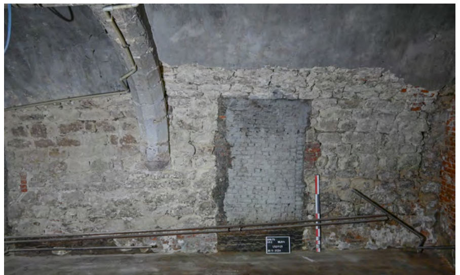
Fig. 3. Mur nord et voûte en pierre de la cave de la maison Grand-Place 6 (© urban.brussels-ULB).
