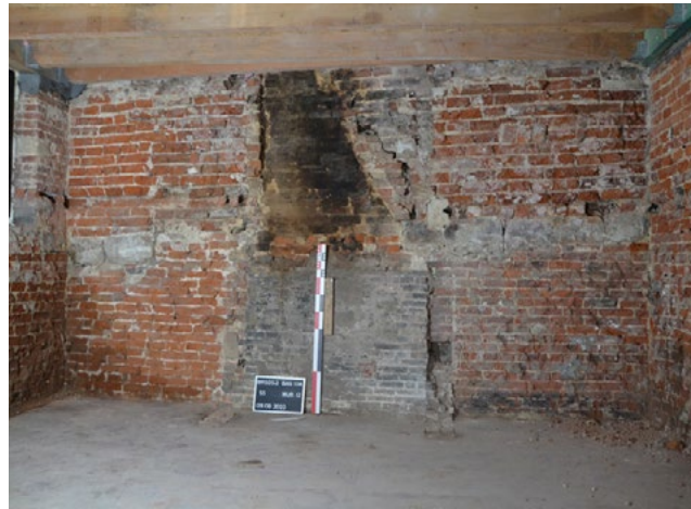
Maison rue des Éperonniers. Mur de fond de parcelle associant différentes maçonneries s'échelonnant de la fin du Moyen Âge au XIX e siècle © urban.brussels-ULB
