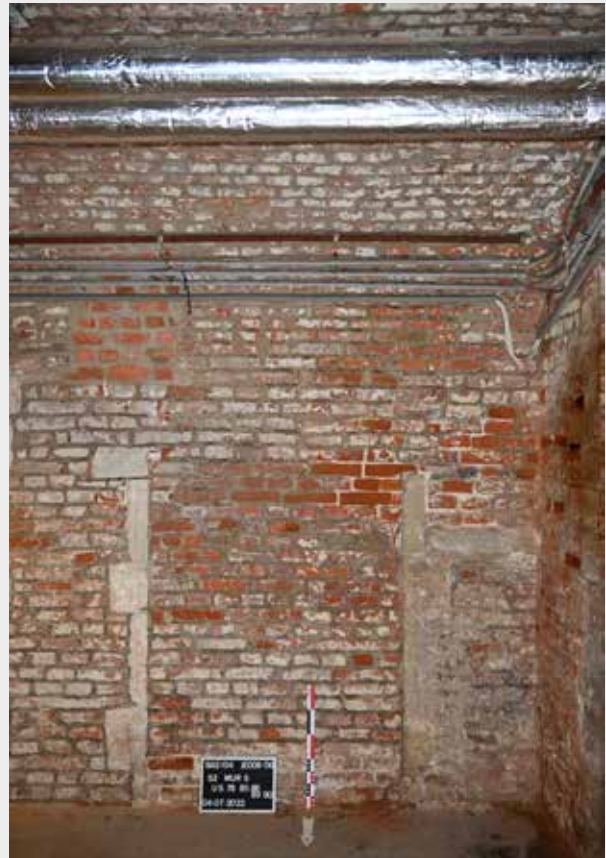
Fig. 3. Vue d'une baie en repentir dans le secteur 2, mur sud. Initialement prévue dans la première campagne (ca 1783), elle est finalement non achevée et rebouchée dans la seconde (fin des années 1780) (© urban.brussels-ULB).
