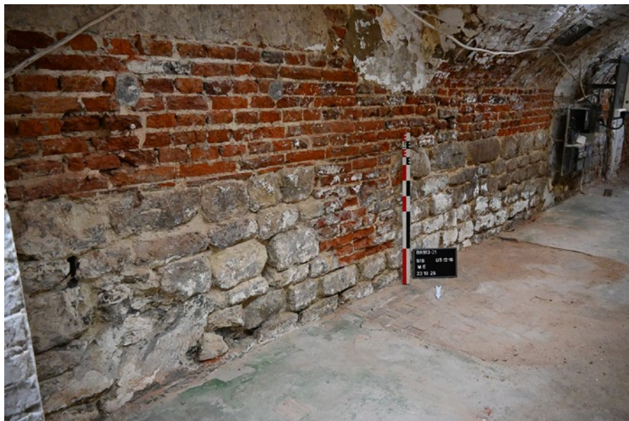
Fig. 2. Grand-Place 36. Mur de cave conservant un segment en moellons de calcaire gréseux rehaussé et complété par une maçonnerie en briques tardo-médiévales (© urban.brussels-ULB).
