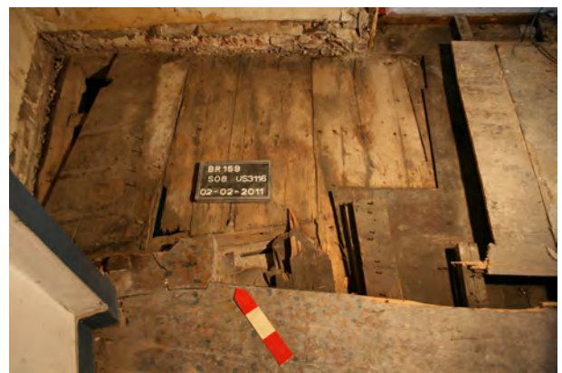
Rue Notre-Dame du Sommeil, détail des différentes strates de planchers (fin du XVII e au XX e siècle).
