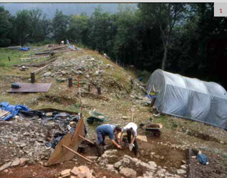
1. Vue générale de la fouille du mur de barrage occidental en 1999 (© ULB).
