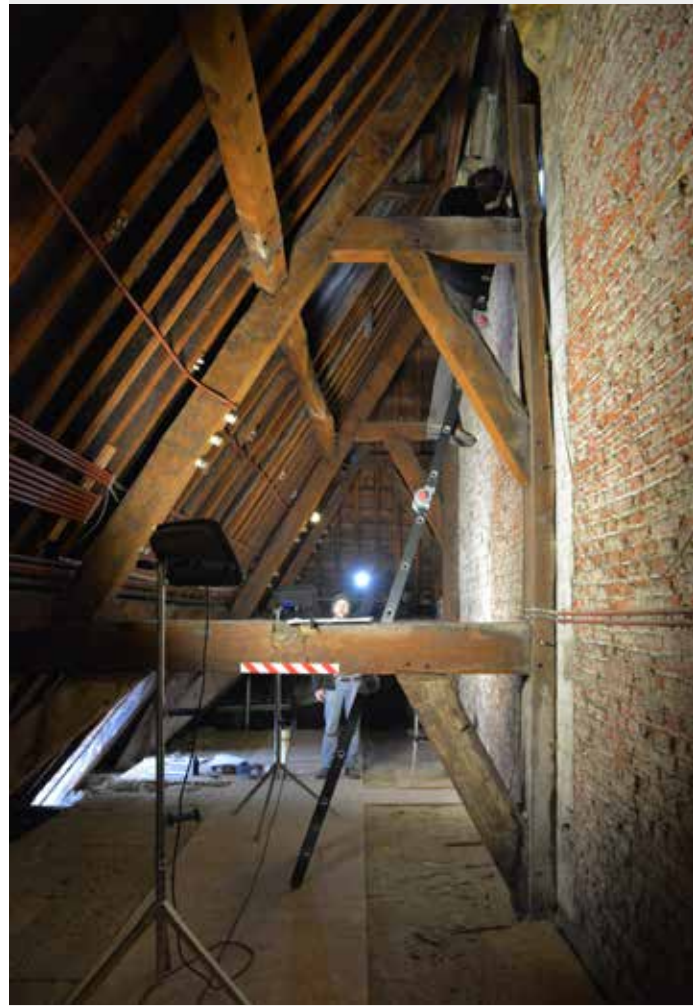
Hôtel de Ville de Bruxelles, étude de la maçonnerie
